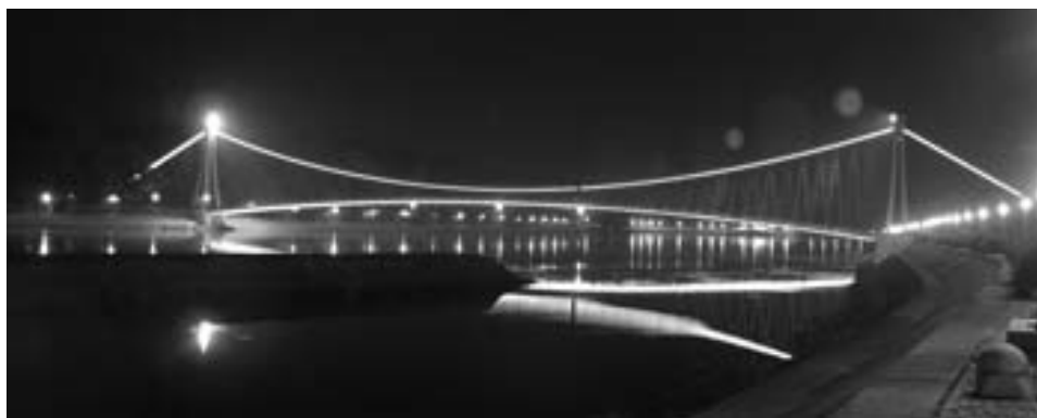
Pješački most noću, Osijek
